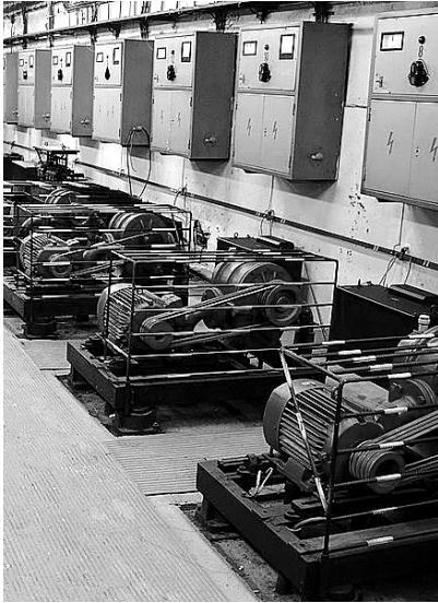
Strojovna potrubní pošty v Jindřichské ulici (vycházka 12. a 23. 6.)
