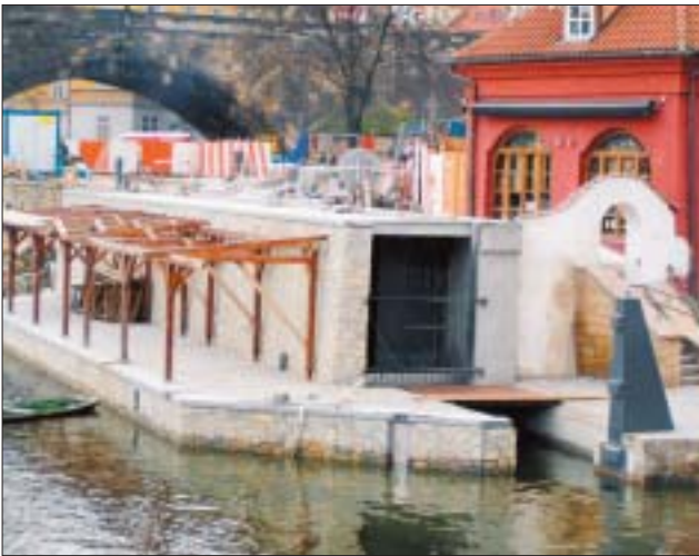
Protipovodňová uzavěra Čertovky
