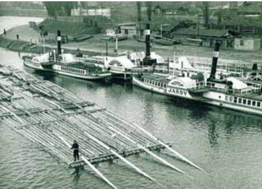
Vory a parníky u železničního mostu, rok 1935.
