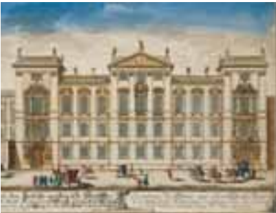
Původní návrhy počítaly se zbouráním do- mů, které dnes brání pohledu na palác.
