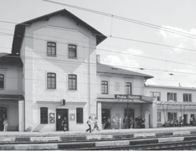
Nádraží v Radotíně
