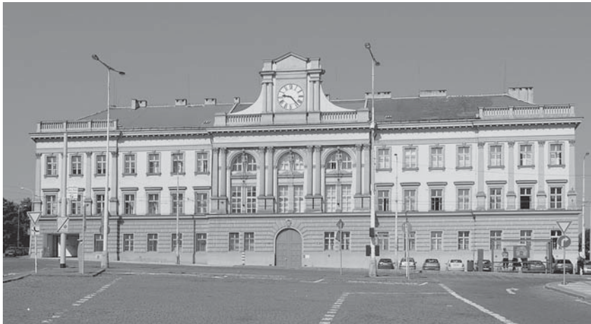
Bývalá kasárna na Pohořelci (Vycházka „Z Pohořelce na Pražský hrad“– 16. 4.)
