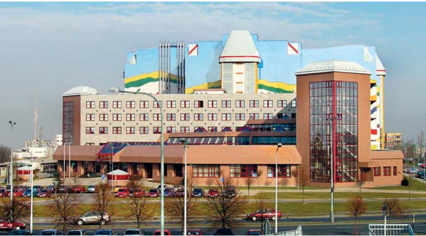
Budova Národního archivu v Praze 4 – Chodovci
