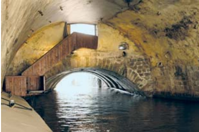
Oblouk Juditina mostu zachovaný pod tělesem Karlova mostu
