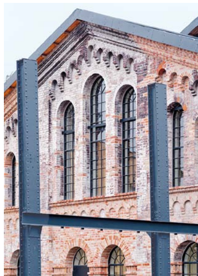
Kladno – Strojovna / Bessemerova ocelárna Vojtěšské huti (foto Viktor Mácha)
