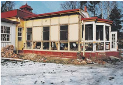
Pohled v průběhu obnovy.
