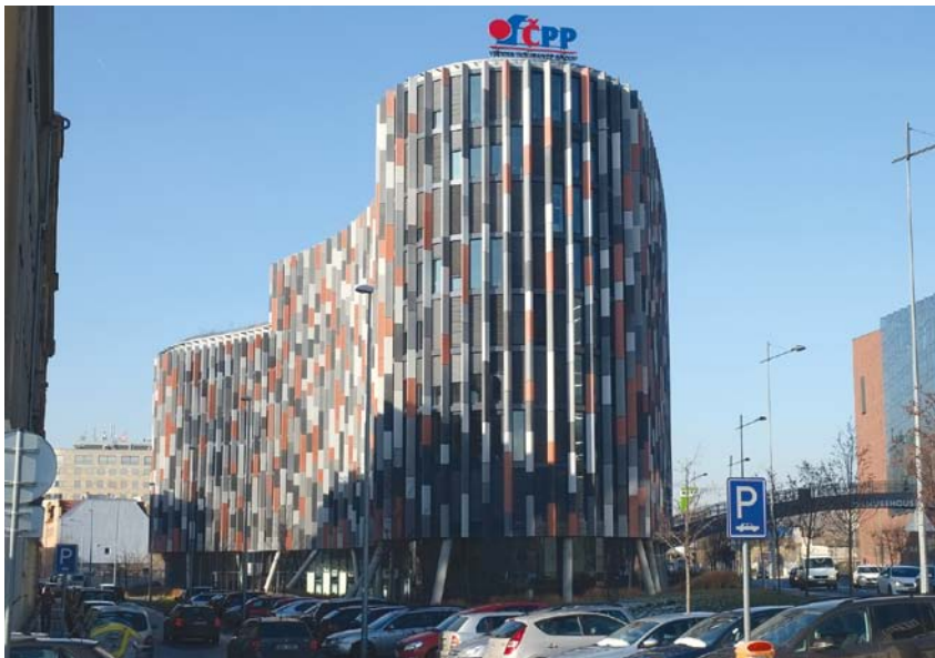
Kancelářská budova Main Point Karlin, foto J. Sládeček (vycházka 30. 3.)
