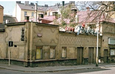
Kino Jiskra na nároží Komenského náměstí a Žerotínovy ulice na Žižkově bylo v provozu pod názvem Deklarace od roku 1922. V listopadu 1977 byla budova zbourána, stejně jako okolní zástavba starého Žižkova, rok 1972, foto Oldřich Janovský, MMP
