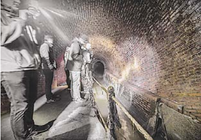
Kmenová stoka ve Stromovce.
