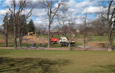
Staveniště jezírka v těchto dnech (duben 2021)
