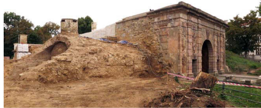
Tajná chodba odhalena při rekonstrukci brány v roce 2014.
